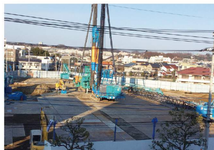
工事が進む 八王子警察署
