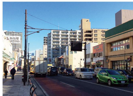
アーケード撤去 完了
