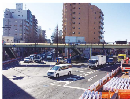
追分歩道橋改築 工事
